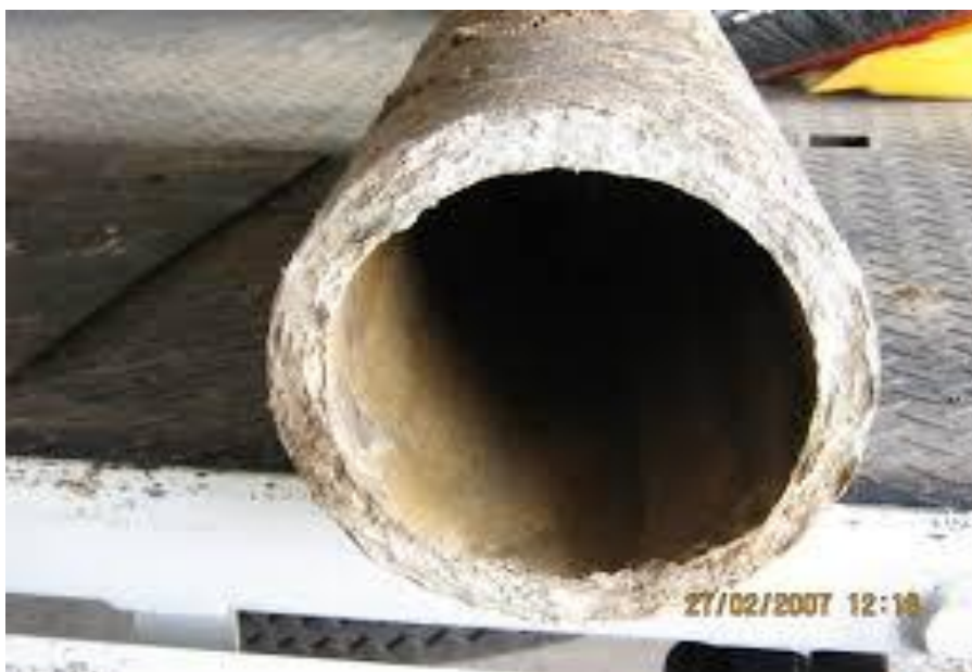
Fig: Asbestos Pipes
